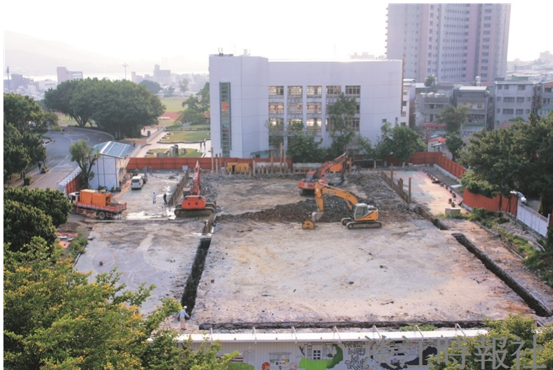
大型機具入校 注意安全 守謙國際會議中心施工中。（攝影／吳國禎）
